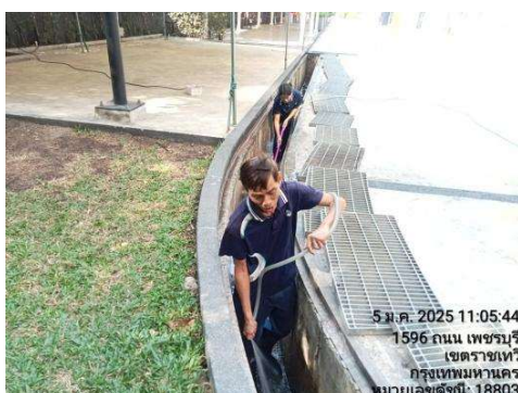
รูปที่ 3.1-42 ตรวจสอบท่อระบายน้ำและบ่อพักน้ำภายในโครงการ
