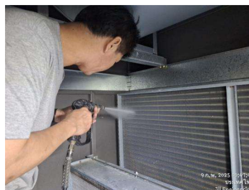
รูปที่ 3.1-43 การล้างแผ่นกรองอากาศและเครื่องปรับอากาศในพื้นที่ส่วนกลาง
