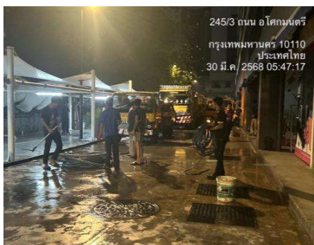
รูปที่ 3.1-39 รถสูบล้างถนนเข้ามาสูบล้างถนน และกากไขมันออกจากระบบบำบัดน้ำเสีย
