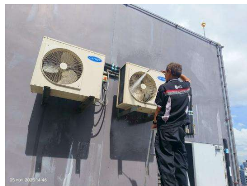
รูปที่ 3.1-43 การล้างแผ่นกรองอากาศและเครื่องปรับอากาศในพื้นที่ส่วนกลาง (ต่อ)
