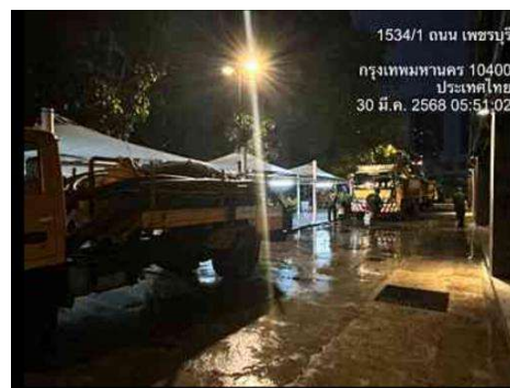
รูปที่ 3.1-39 รถสูบล้างถนนเข้ามาสูบล้างถนน และกากไขมันออกจากระบบบำบัดน้ำเสีย
