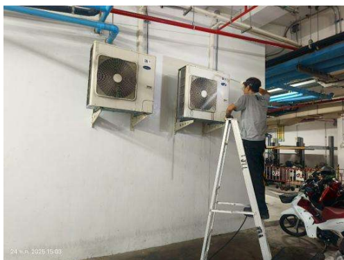
รูปที่ 3.1-43 การล้างแผ่นกรองอากาศและเครื่องปรับอากาศในพื้นที่ส่วนกลาง (ต่อ)
