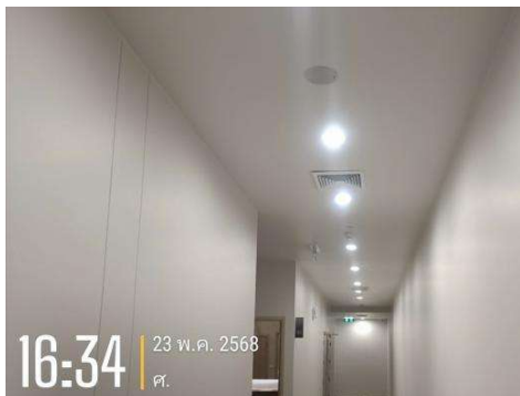
รูปที่ 3.1-25 หลอดไฟฟ้าชนิดประหยัดไฟแบบ LED
