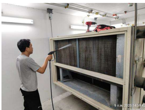
รูปที่ 3.1-43 การล้างแผ่นกรองอากาศและเครื่องปรับอากาศในพื้นที่ส่วนกลาง
