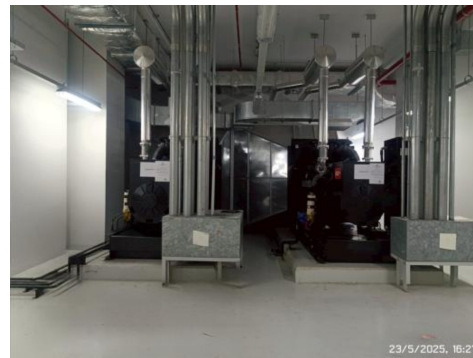
รูปที่ 3.1-24 หม้อแปลงไฟฟ้า และเครื่องสำรองไฟฟ้า
